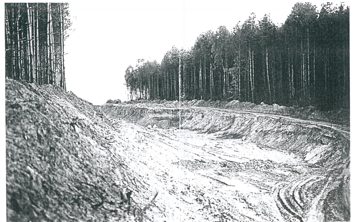
77. Przejście przez dolinę Radwii – wykop drogi, budowa obwodnicy.
