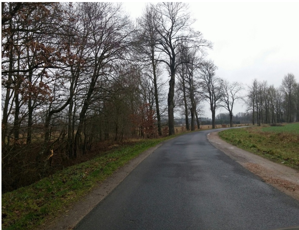
Zdj. 5. Miejsce przecięcia trasy kolei wąskotorowej z drogą gminną asfaltową prowadząca do m. Kamasowo
