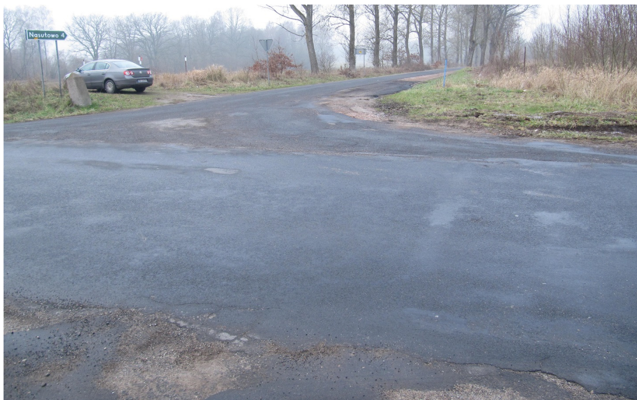
Zdj. 3. Skrzyżowanie drogi powiatowej przy kierunku Białogard – Stanomino, Łęczno – Nasutowo. W prawie części zdjęcia widoczna naprawa nawierzchni asfaltowej w miejscu, w którym przebiegała niegdyś trasa kolei wąskotorowej.
