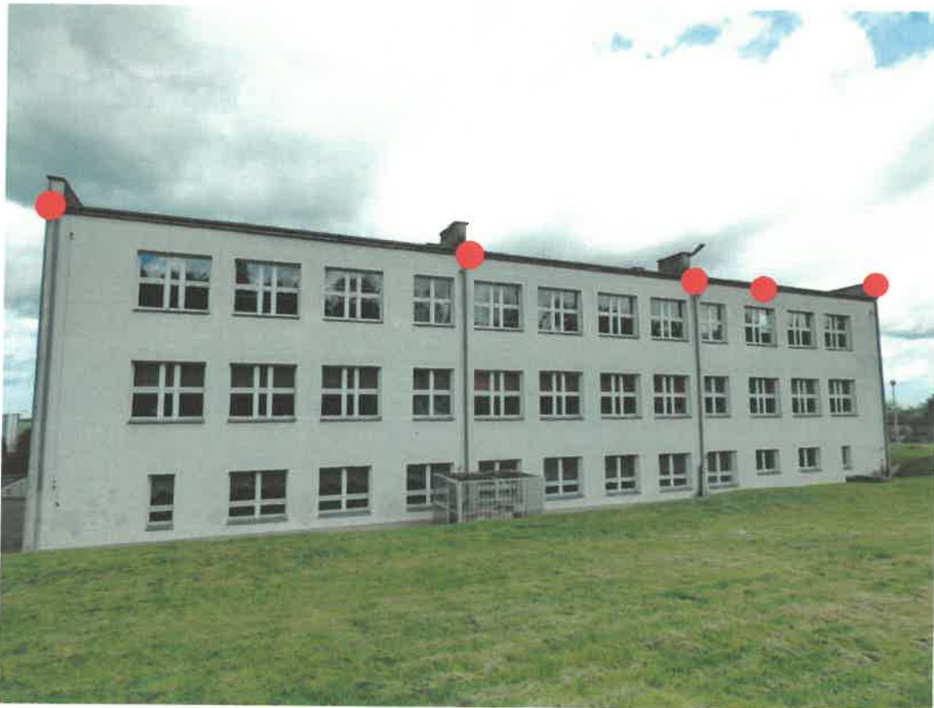
Fot.4 Ściana tylna budynku z zaznaczonymi lokalizacjami nisz lęgowych ptaków.
