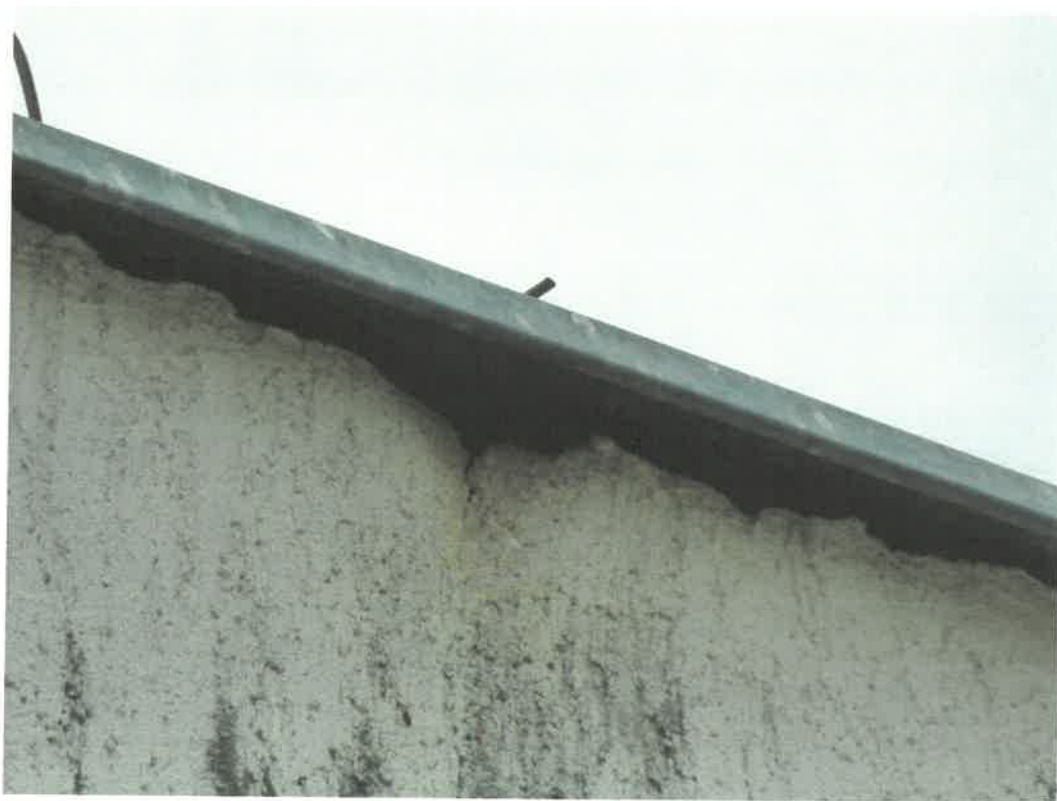
Fot.12 Nisza lęgowa wróbla na ścianie bocznej.
