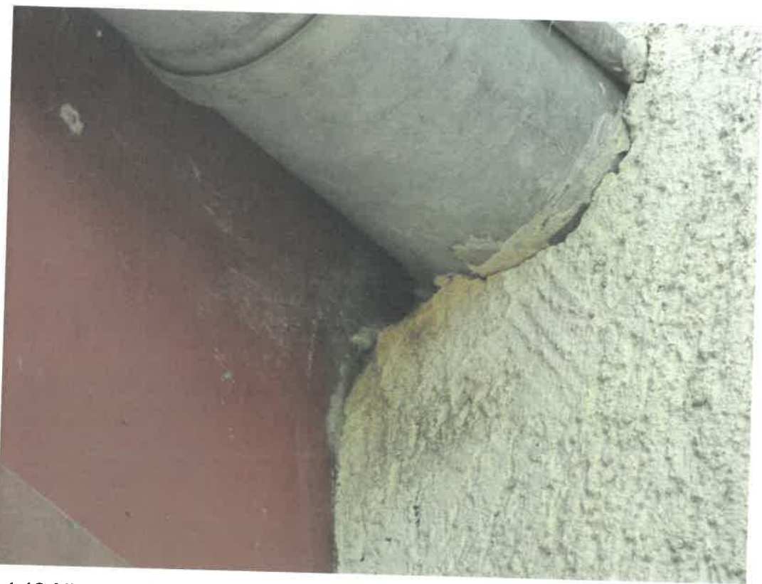
Fot.13 Nisza lęgowa wróbla na ścianie bocznej.
