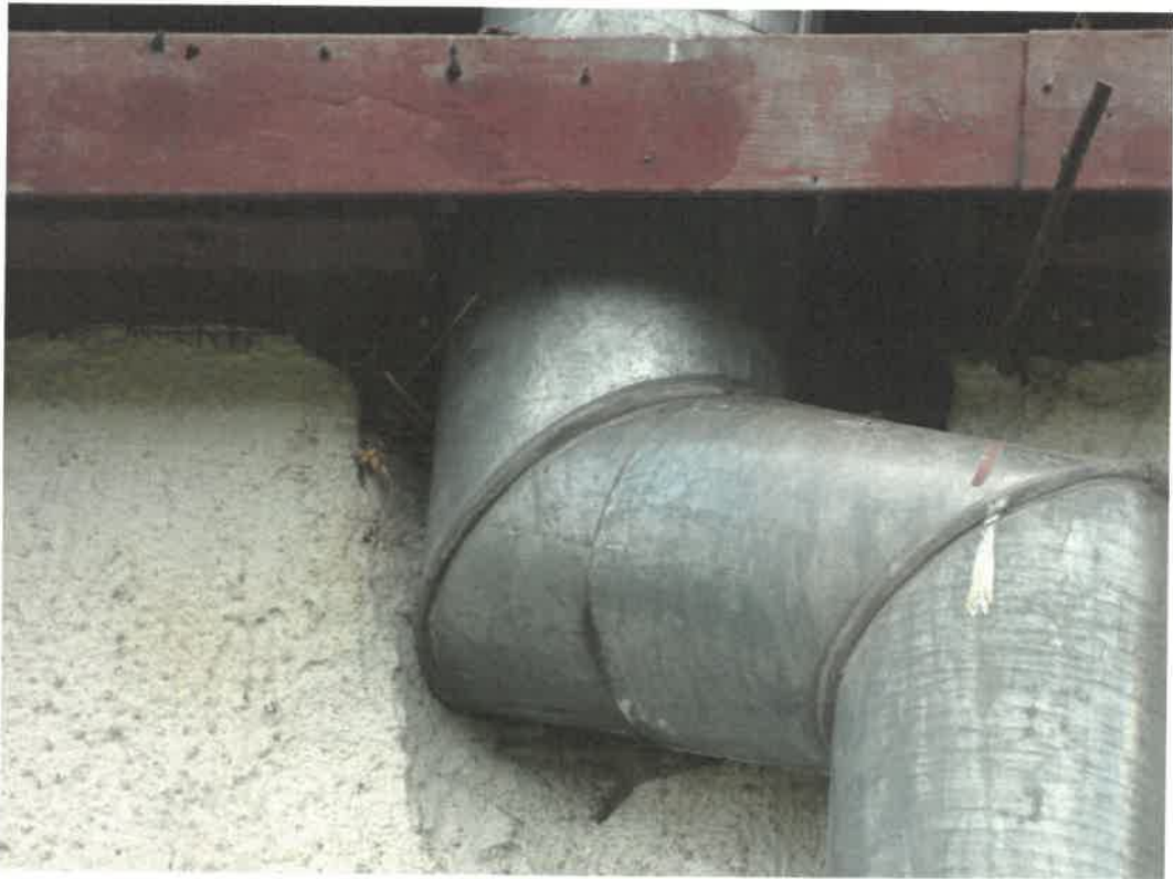
Fot. 5 Nisza lęgowa wróbla pod opierzeniem blacharskim ściany tylnej.
