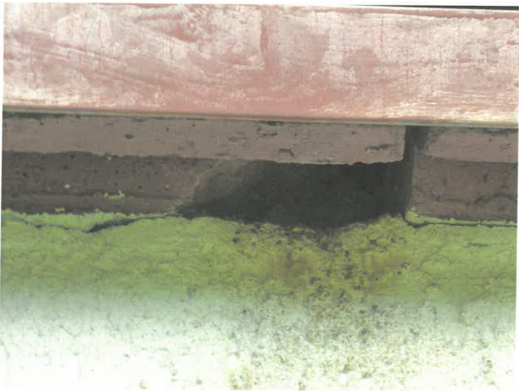
Fot. 6 Nisza lęgowa wróbla pod opierzeniem blacharskim ściany tylnej.
